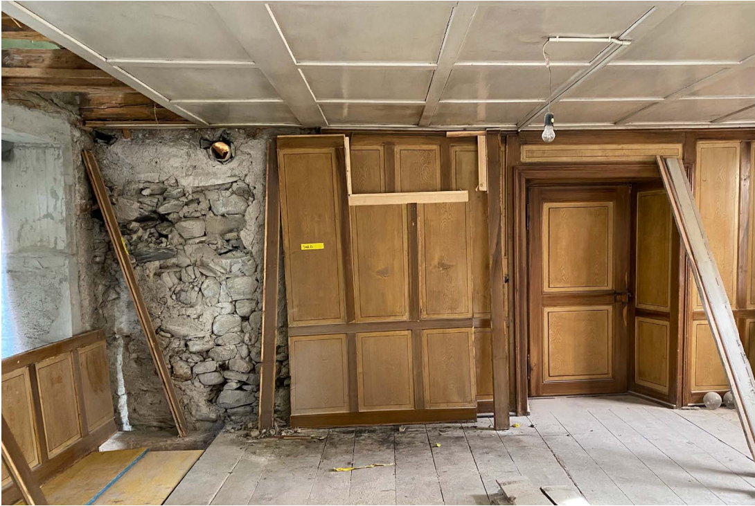
Abb. 9: Täfer aus Tannenholz veredelt mit Nussbaum und Eichenimitation – Faux Bois (Foto: Curschellas & Gasser Architekten)
