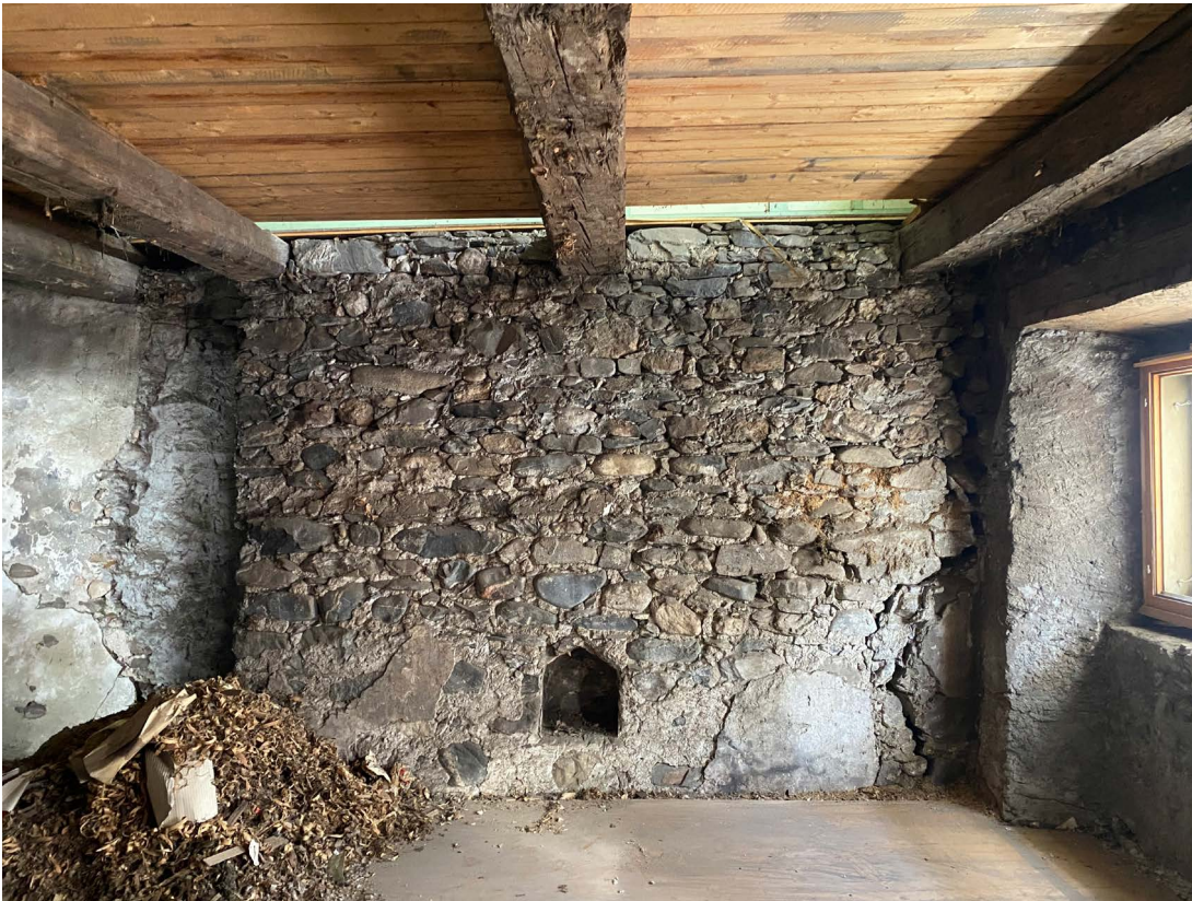
Abb. 10: Bestehendes Mauerwerk, Balken der La Stivetta (Foto: Curschellas & Gasser Architekten)
