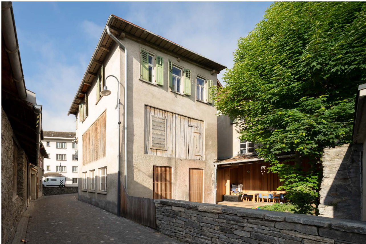
Abb. 4: Rathausgasse Stallscheune mit Erweiterung (Foto: Jaromir Kreiliger)
